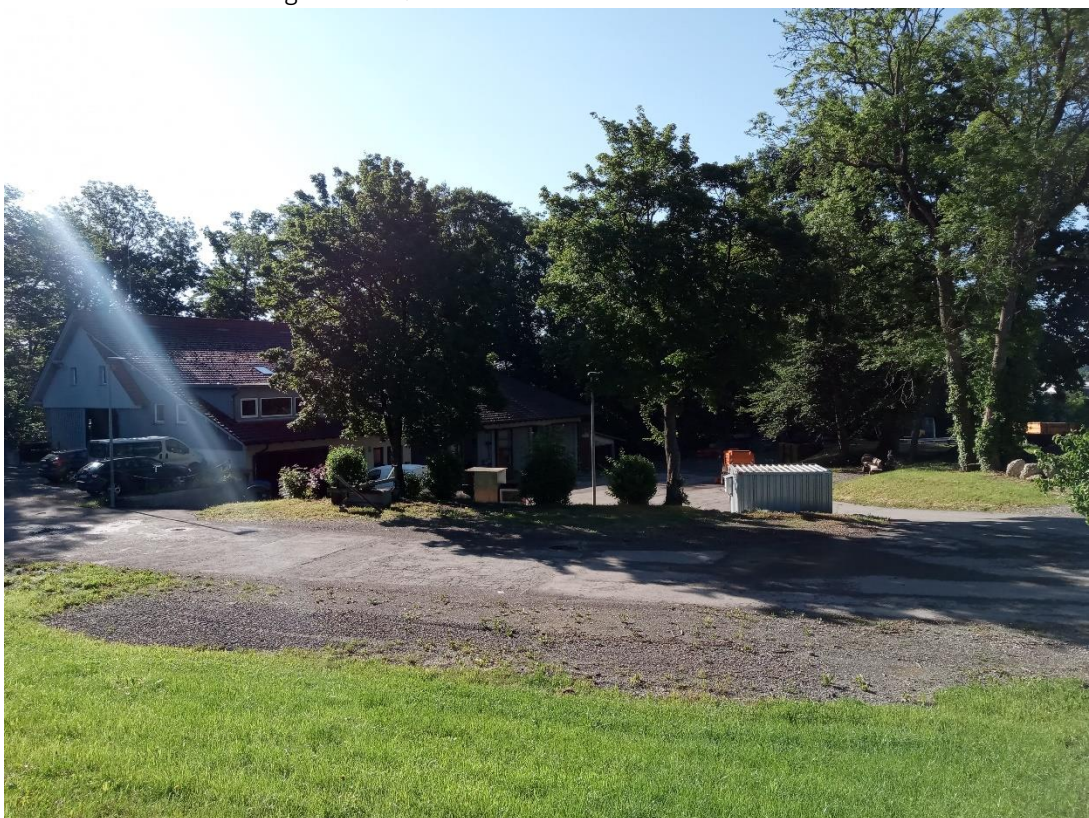
Der westliche Bauhof wird im Zuge des B-Planverfahrens um- bzw. ausgebaut.
